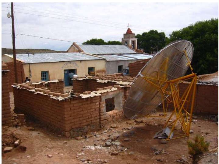
Figura 9: Construcción de una cocina comunitaria en la comunidad de Cusi Cusi y una pequeña cocina parabolica en el kinder.
