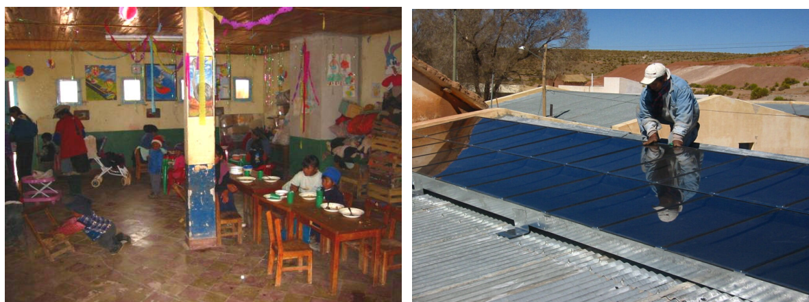
Figura 4: Sala de esparcimiento y colectores solares para la calefacción de piso en Cusi Cusi.
