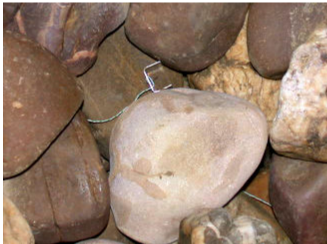
Abbildung 4-13: Temperatursensor im Kiesbettspeicher
