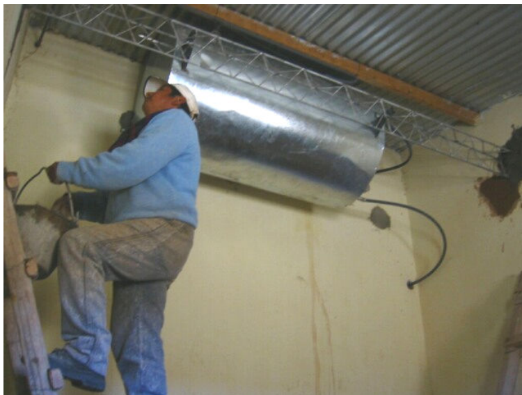
Abbildung 5-10: 400 Liter Warmwassertank für den Kindergarten Cusi Cusi
