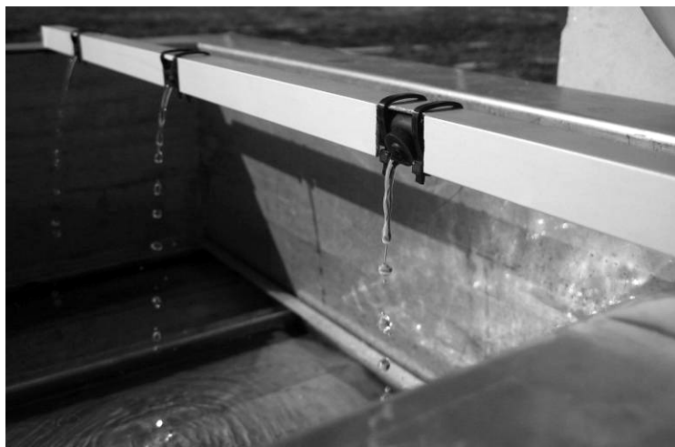
Abb. 12-1: Zulaufverteiler für drei Wannen
