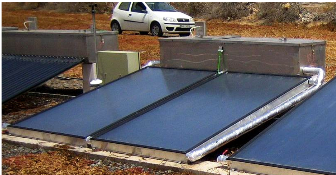
Abb. 13-2: Entsalzungsmodul mit Flachkollektoren (STU-VNA) im Feldtest
