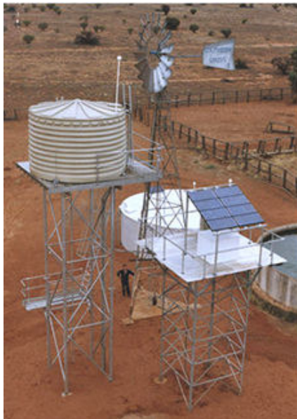
Abb. 2-9: Solarbetriebene Umkehrosmoseanlage mit einer Tagesleistung von 1m 3 /d in Australien
