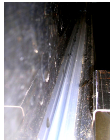
Abb. 11-4: Dichtlippe aus Silikon an den Wannenrändern im Schnitt und im eingebauten Zustand
