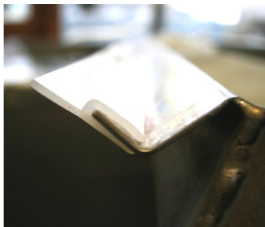
Abb. 11-4: Dichtlippe aus Silikon an den Wannenrändern im Schnitt und im eingebauten Zustand
